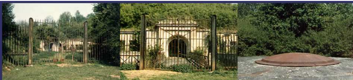
Les grilles extérieures
